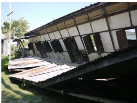
クシ村で倒壊した小学校
