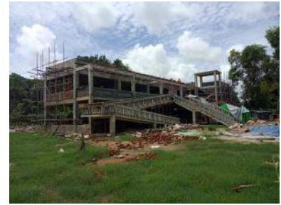
躯体工事が完了した学校
