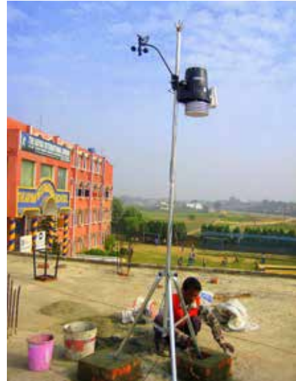
自動気象観測装置を設置しているところ
