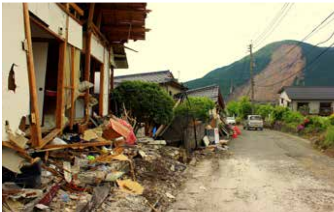
南阿蘇村の被害。住宅の多くは1階部分が潰れ、山腹では土砂災害も発生した
