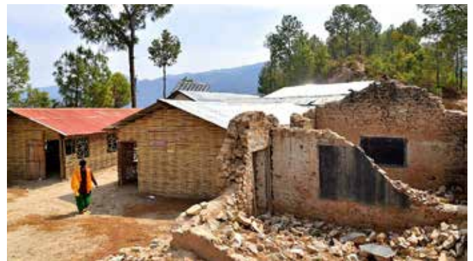
地震から1年、被災校はまだ再建されず、仮設校舎での授業が続いている
