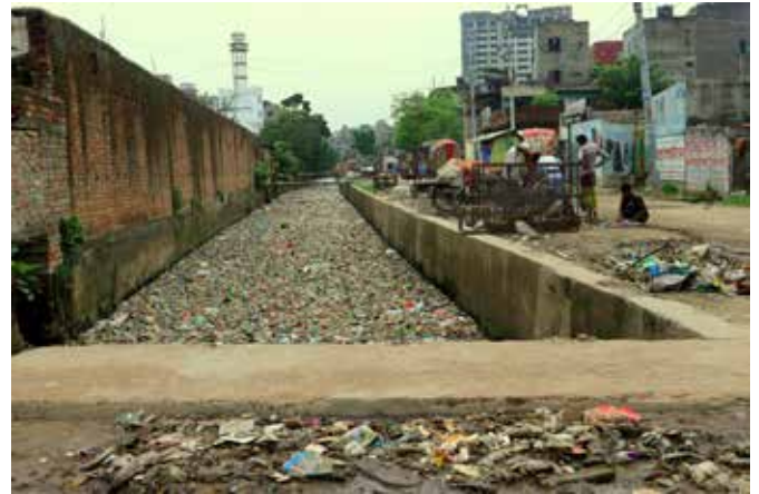
ゴミであふれた排水溝
