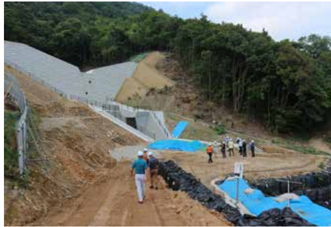
広島土砂災害被災地での砂防ダムの視察
