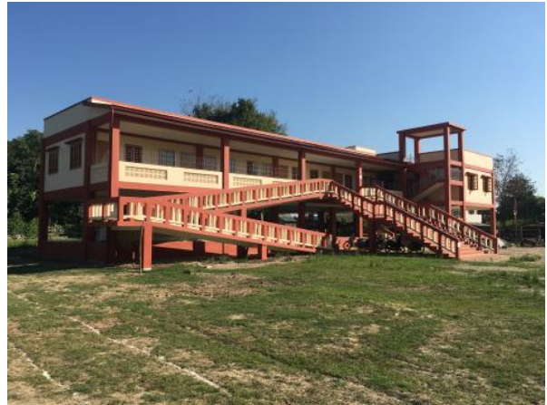
校舎の建設が完了したナバーゴン村の学校兼シェルター
